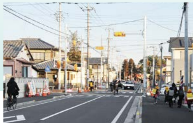
六供町八幡宮南方の通学路に信号機を新設 (1月16日撮影)
