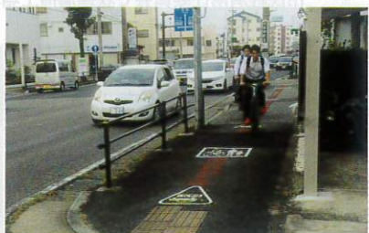
南部大橋線(南町四丁目)街路樹根盛り上がり等を平らに整備(10月9日撮影)
