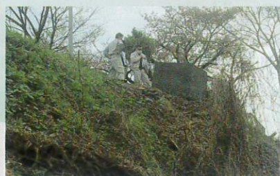
コンクリート柵を撤去し落下危険回避(4月4日撮影)
